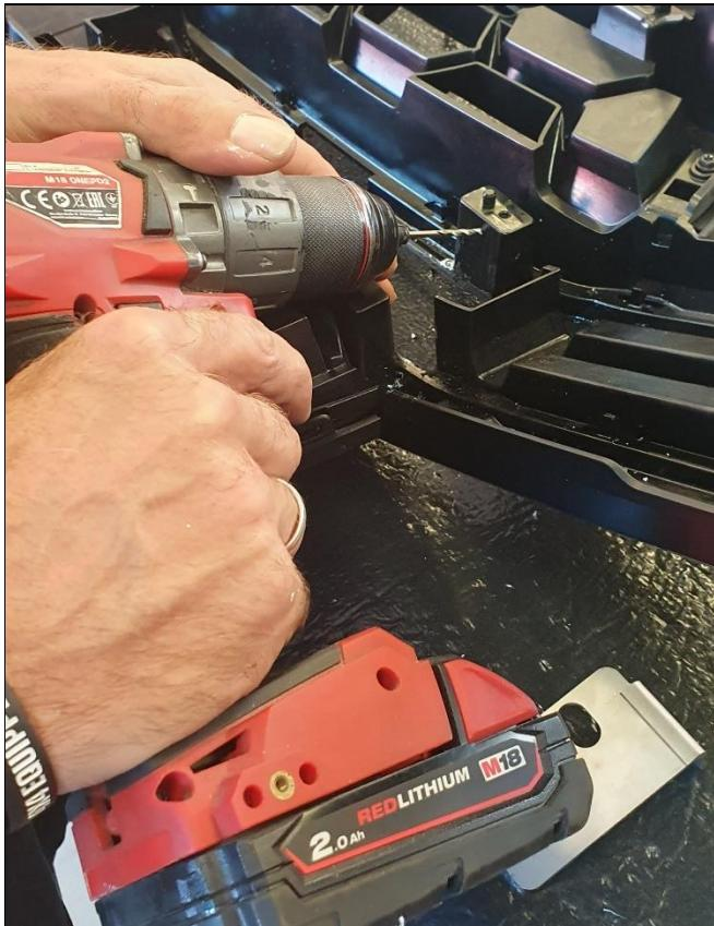
Löcher mit 2,5 mm vorbohren
